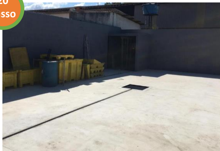
Construção de abrigo da área de lavagem.
