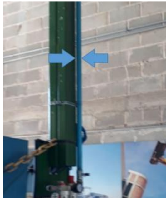
- Fixação com Abraçadeiras
